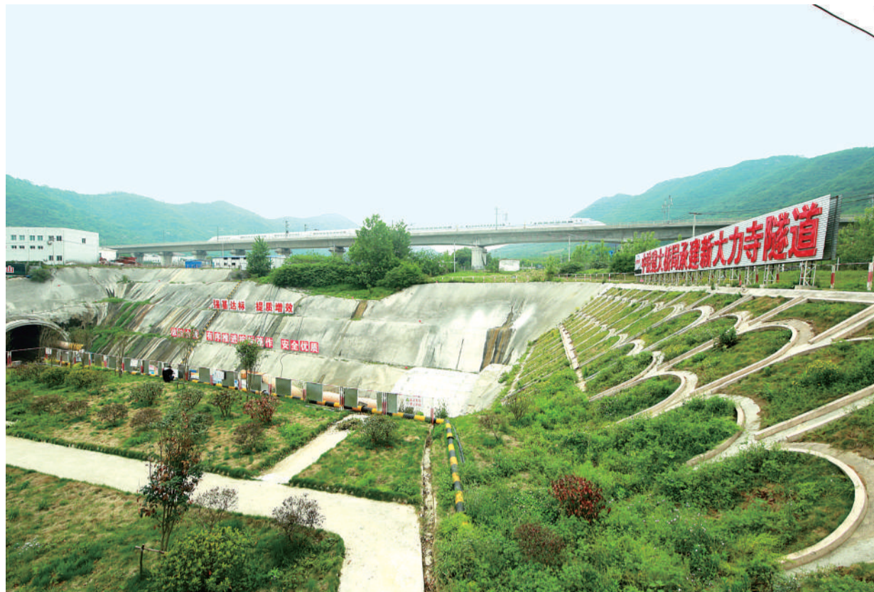
正在建设中的商合杭高速铁路新大力寺隧道外观环境。
