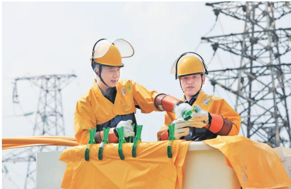
左图 南方电网广东佛山供电局员工顶着高温，穿着绝缘披肩开展带电作业。
