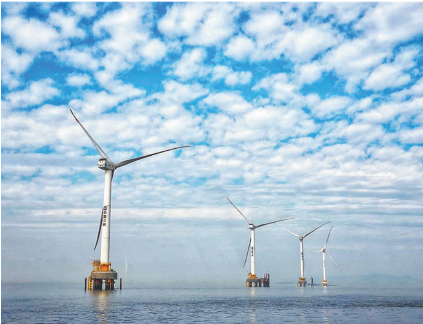
图为建设中的福清兴化湾30万千瓦海上风电场一期工程。王轶辰摄
