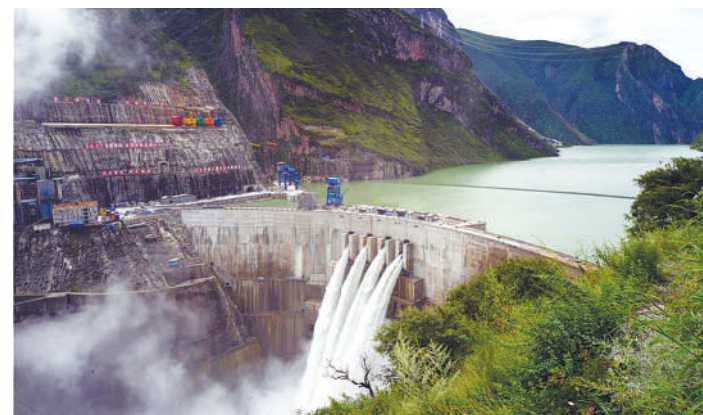
锦屏一级水电站场景。
