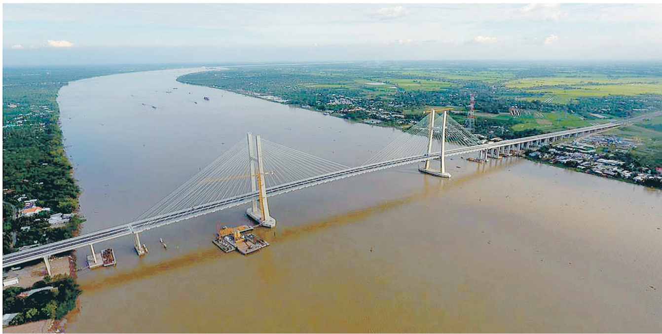
由中国路桥工程有限责任公司承建的越南跨湄公河高岭桥项目日前竣工通车。
