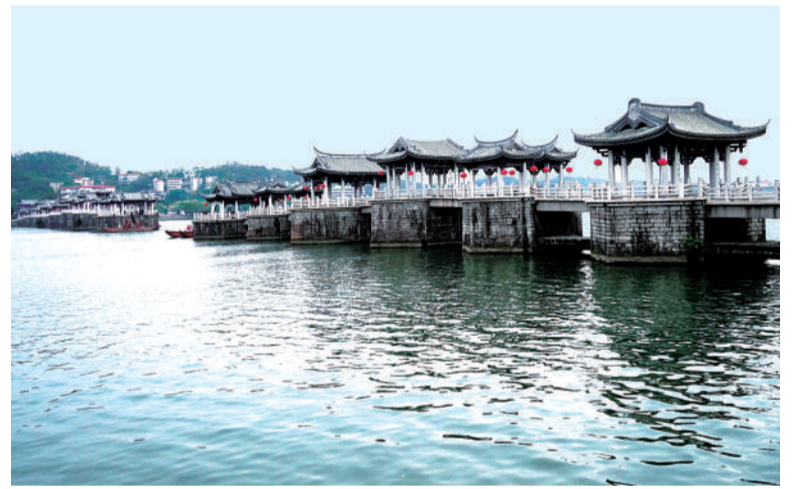
横跨韩江的潮州广济桥,中间有一段用船只连接,遇有洪汛,可解开船只让出航道。
