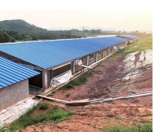
江西赣州市信丰县古陂镇太平天光伏发电及生猪养殖“二位一体”，贫困户可享受固定的入股分红和利润再分配收益。
