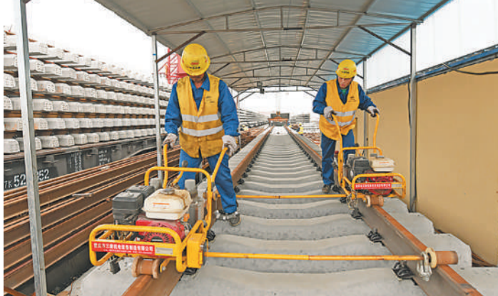
5月22日，湖北襄阳蒙华铁路襄州制梁场，中铁十一局三公司开始轨排生产，标志着蒙华铁路湖北段全面铺轨启动。蒙华铁路是国内最长运煤专线，中铁十一局承担河南内乡至湖北荆州的正线铺架任务。刘曙松摄
