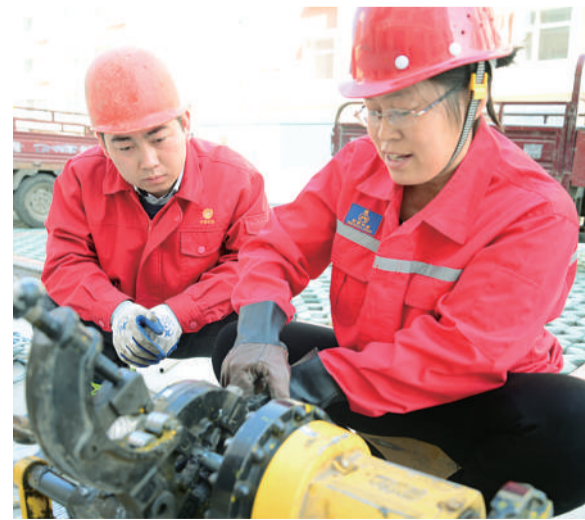
范金梅(右)给徒弟做管道焊接的示范。
