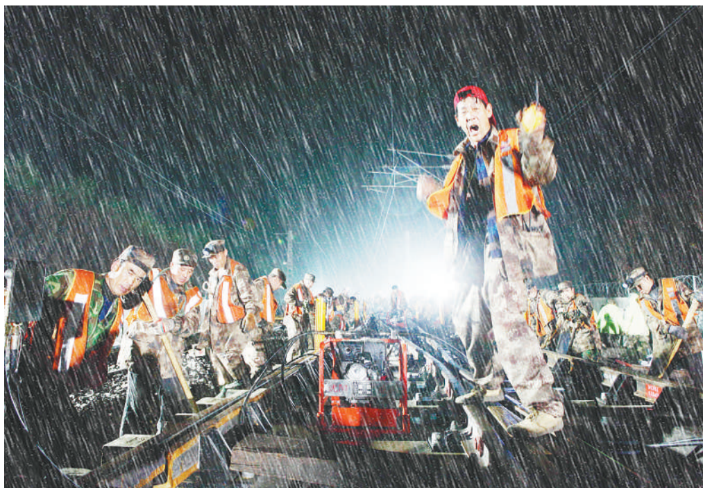
北京铁路集团公司工人冒雨更换新组道岔入位。 吴晓强摄
