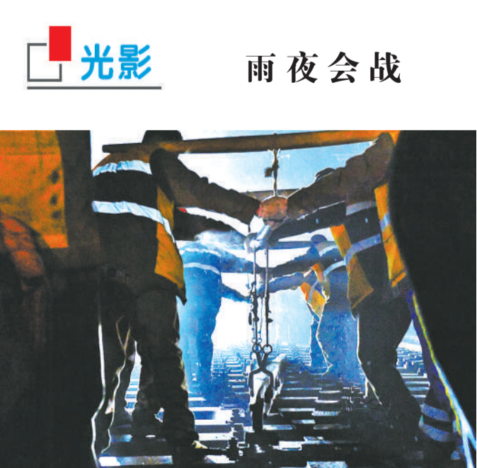
京哈铁路上，施工者齐心协力更换道岔。孙立君摄
