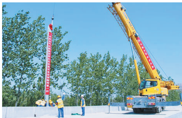
4月19日,中国中铁电气化局三公司商合杭项目部在河南商丘成功组立接触网第一杆,标志着商合杭高铁河南段四电工程全面启动。商合杭高铁(商丘—合肥—杭州)是国家八纵八横高速铁路网的重要组成部分,建成后有利于中原地区与长三角地区交通的“无缝对接”。于雪珂摄
