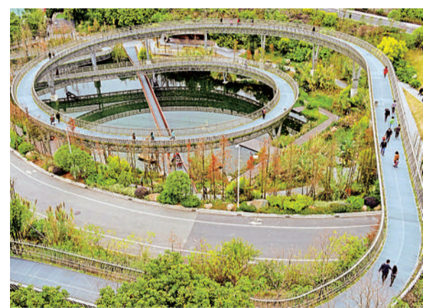
“福道”主体采取空心钢管桁架组成,既不妨碍植被生长,又可以让市民获得穿梭林间漫步的体验。
