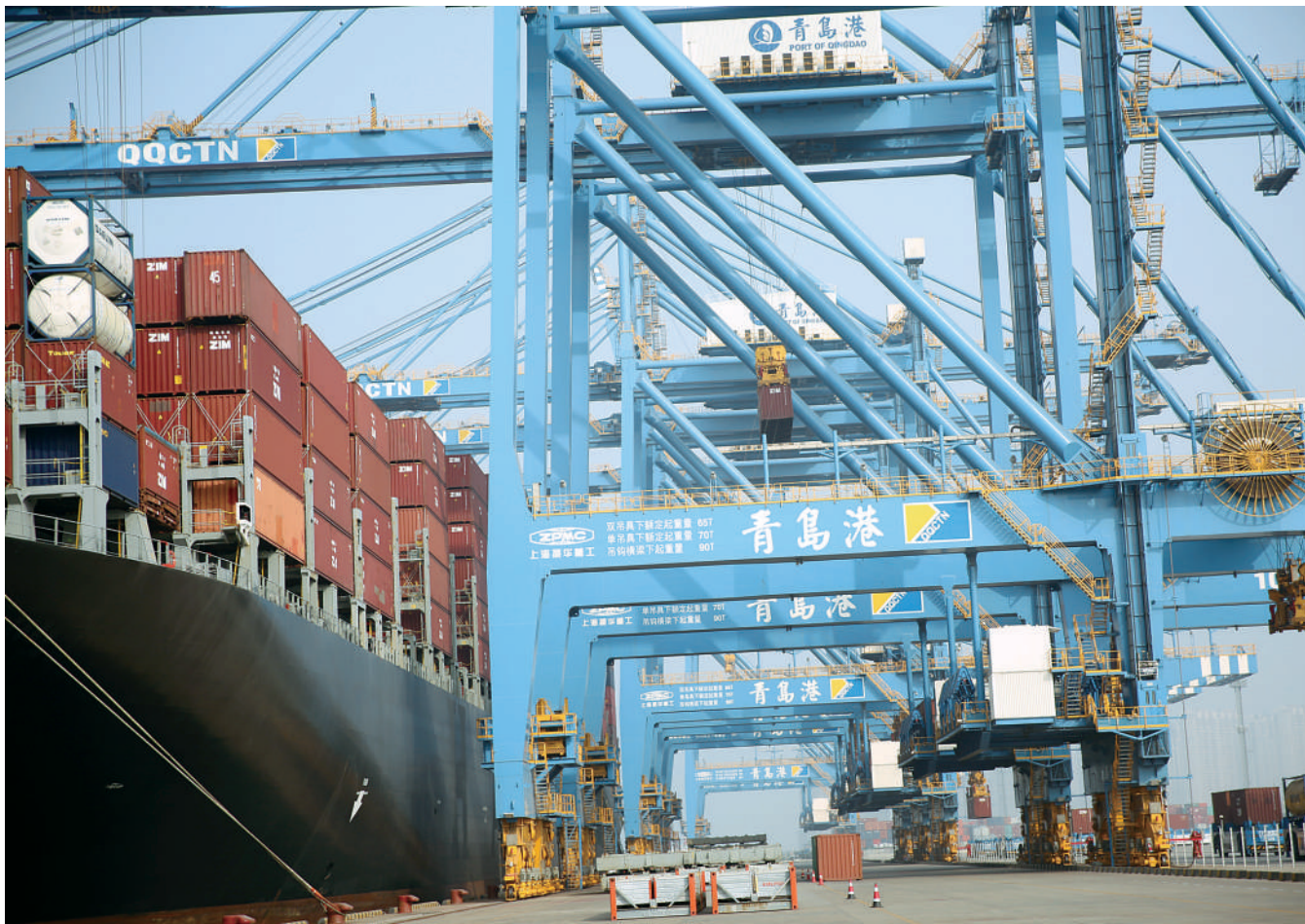
图为山东青岛港自动化码头。
