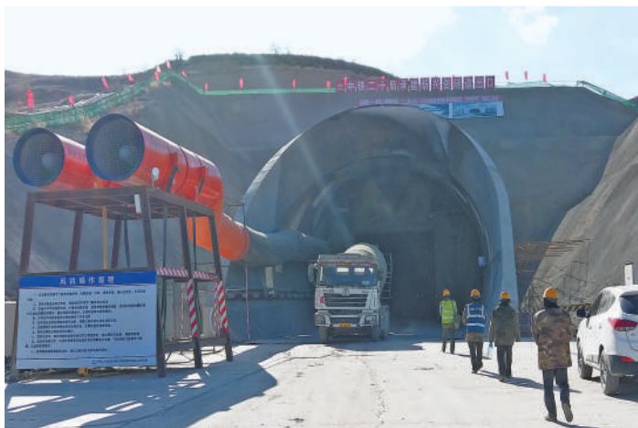
2月4日,一辆工程车从崇礼城际铁路新兴堡隧道施工现场驶出。当日,由中铁二十局承建的北京2022冬奥会重点配套交通工程——崇礼城际铁路新兴堡隧道掘进破千米大关。据介绍,该隧道全长2132米,计划于今年6月贯通,目前已掘进过半。
