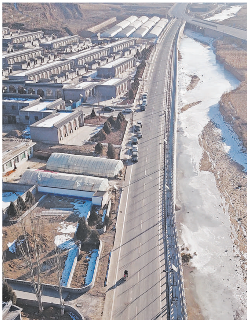
这是山西省吕梁市临县城镇镇的新修道路(1月23日摄)。新华社记者 才扬摄
