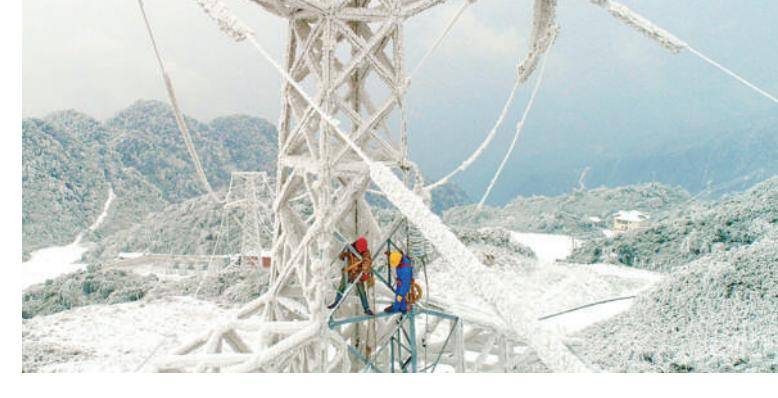
2月2日，重庆市万盛经开区石林镇茶园村里，电力工人在电塔上抢修线路。因气温持续走低以及连日来的大雪冰冻，南渝110千伏电网高压供电线路出现断续。该区供电部门迅速组织力量抢险救援，确保辖区居民正常用电。
