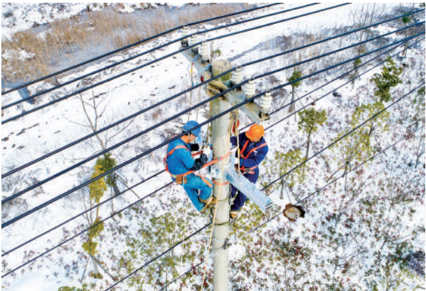
安徽铜陵市义安区顺安镇金桥工业园内，国网铜陵市义安区供电公司施工人员日前在对一处10千伏线路杆塔进行迁改。连日来，施工人员冒风雪、抗严寒，积极做好负荷转供、线路巡视等保供电工作。 陈 晨摄
