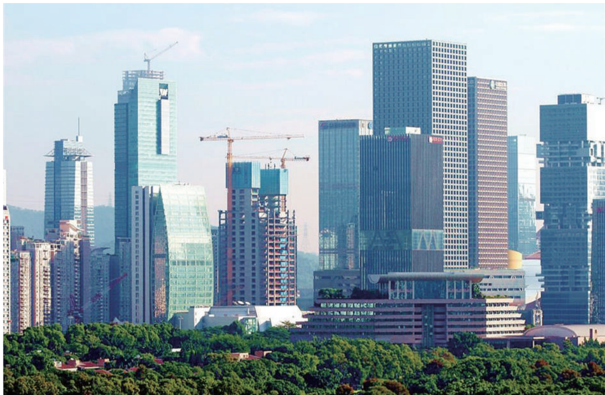
深圳市福田区中心城区在建项目。
