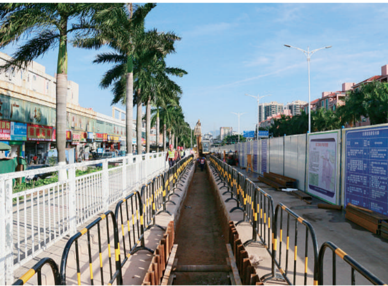
茅洲河综合整治工程福和路回填施工段。
