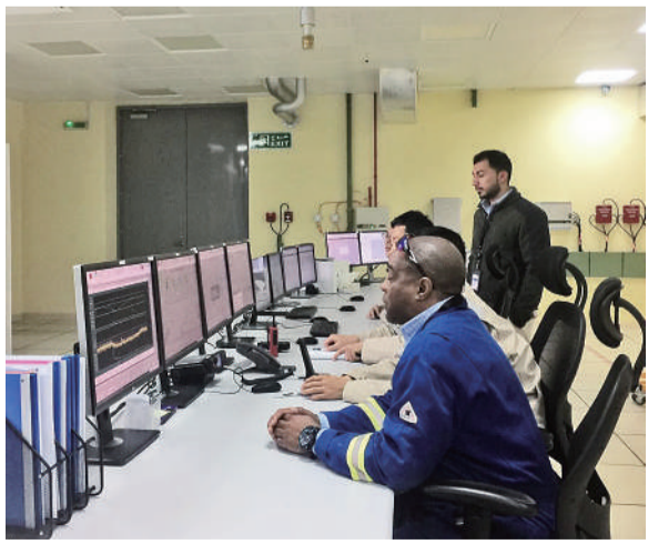
伊拉克鲁迈拉早期电站项目的总调度室。
