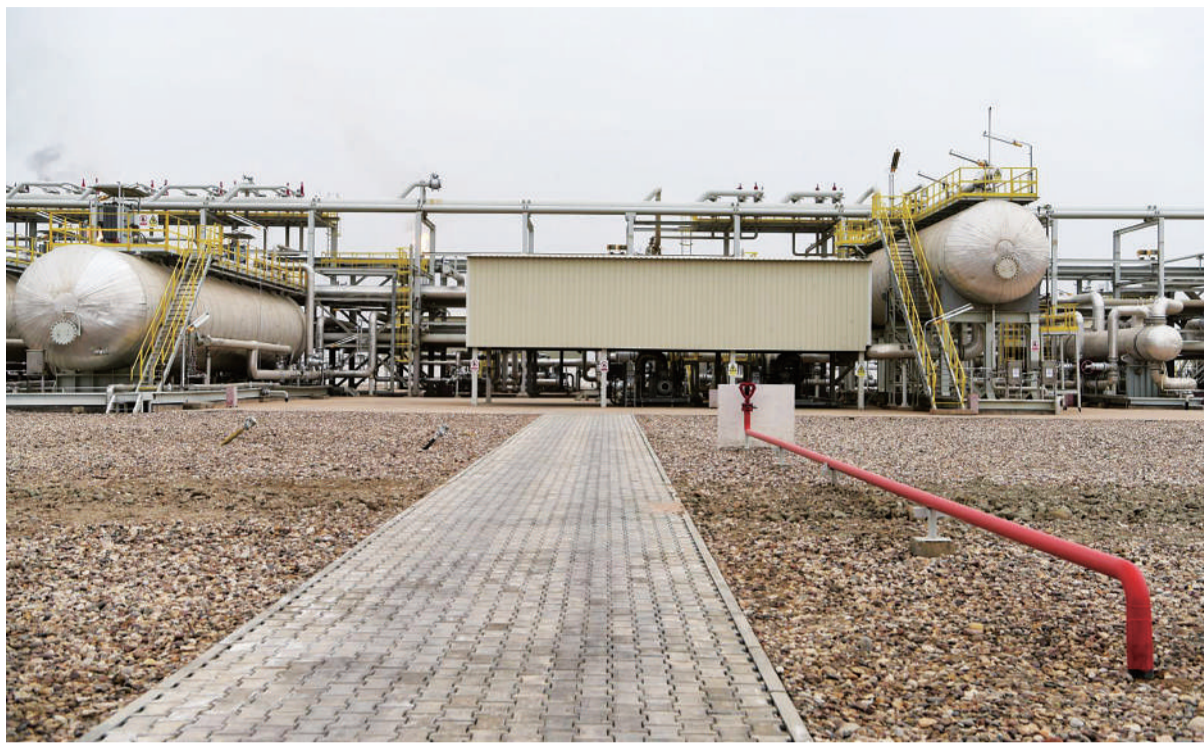
中国石油工程建设公司伊拉克分公司在鲁迈拉早期电站项目的施工现场。
