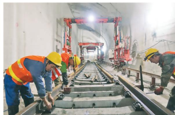
12月29日,中铁四局八分公司施工人员对重庆地铁四号线一期轨道工程进行轨排施工。重庆地铁四号线一期计划于近日实现“短轨通”,于2018年2月实现“长轨通”,7月份正式开通。 郑红梅摄
