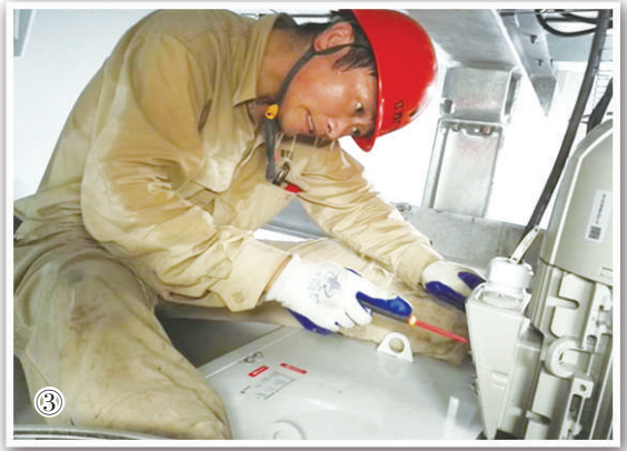
图① 东台风电项目海上风机。 图② 吊装特写。 图③ 工作人员正在检查变压器冷却风扇电机接线。
