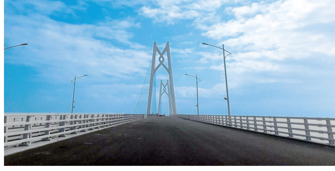
器人焊接的钢桥。港珠澳大桥管理局副局长柴瑞介绍，钢桥焊接时，钢材料在不均匀的加热和冷却收缩后，会产生很大的自身应力。“所以我们采用多头焊接机器人来实现均匀焊接。多头焊机同时焊接，避免了冷热不均，消除因焊接工艺产生的内部应力。”
