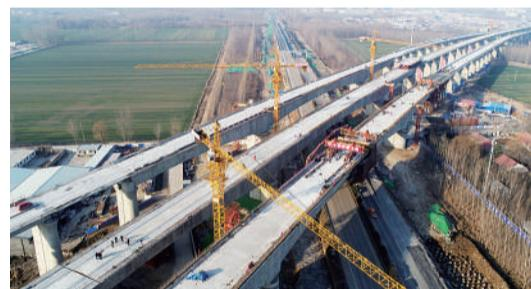
△12月20日，济（南）青（岛）高铁路跨济（南）广（州）高速128米连续梁完成全部合龙，标志着济青高铁的线下工程全线贯通。（新华社发）
