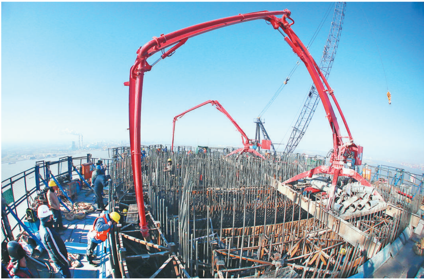
沪通长江大桥主墩 施工高度超200米
