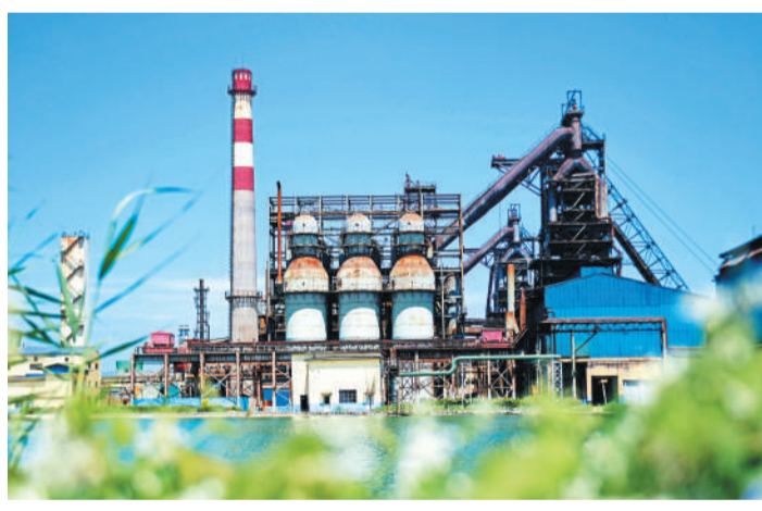
这是霸州市新利钢铁有限公司。2017年7月底,该公司产能整体退出、设备封存通过河北省验收,将于年内全部拆除。新华社记者 王 晓摄
