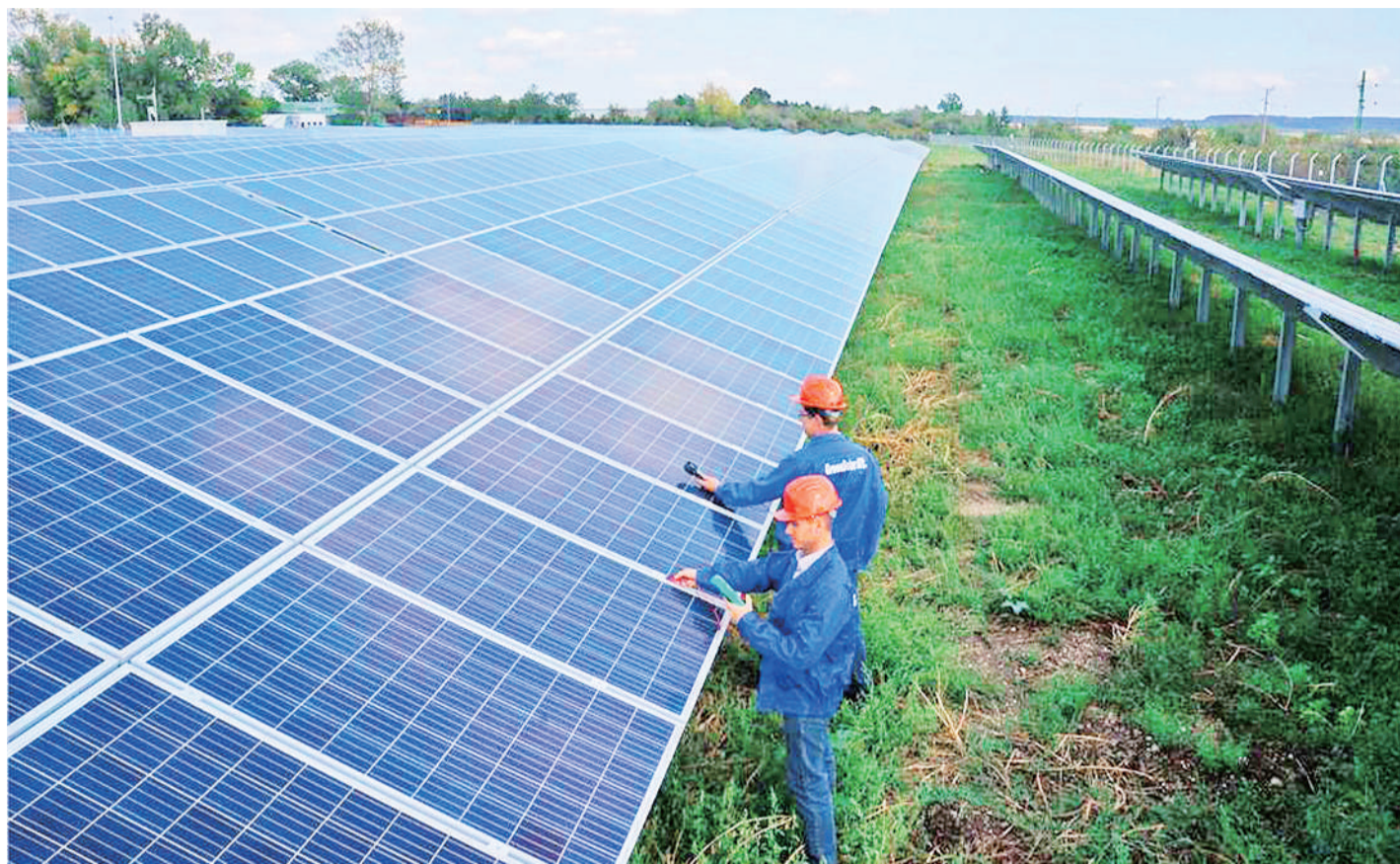
由北京七星华电科技集团在匈牙利建成和并网发电的1.8兆瓦晶硅太阳能小型光伏电站,占地3.6公顷,设计寿命25年,共安装有6666块组件,预计年发电量为198万千瓦时,每年可减少碳排放600余吨。图为工作人员在做检测。
