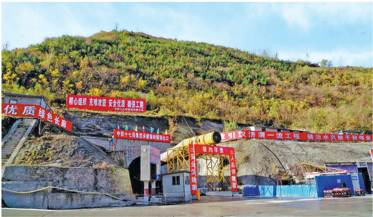
11月25日，世界最长水利隧洞引汉济渭秦岭隧洞出口段贯通。
