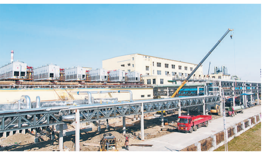
近日，吉林省吉林市经济技术开发区康乃尔化工60万吨甲醇制烯烃项目一期工程告竣，开始试车。吉林经开区积极推进项目建设早落地、早开工、早见效，今年前三季度5000万元以上项目45个，其中新建11个，续建35个，项目总投资254.5亿元。 李景辉摄
