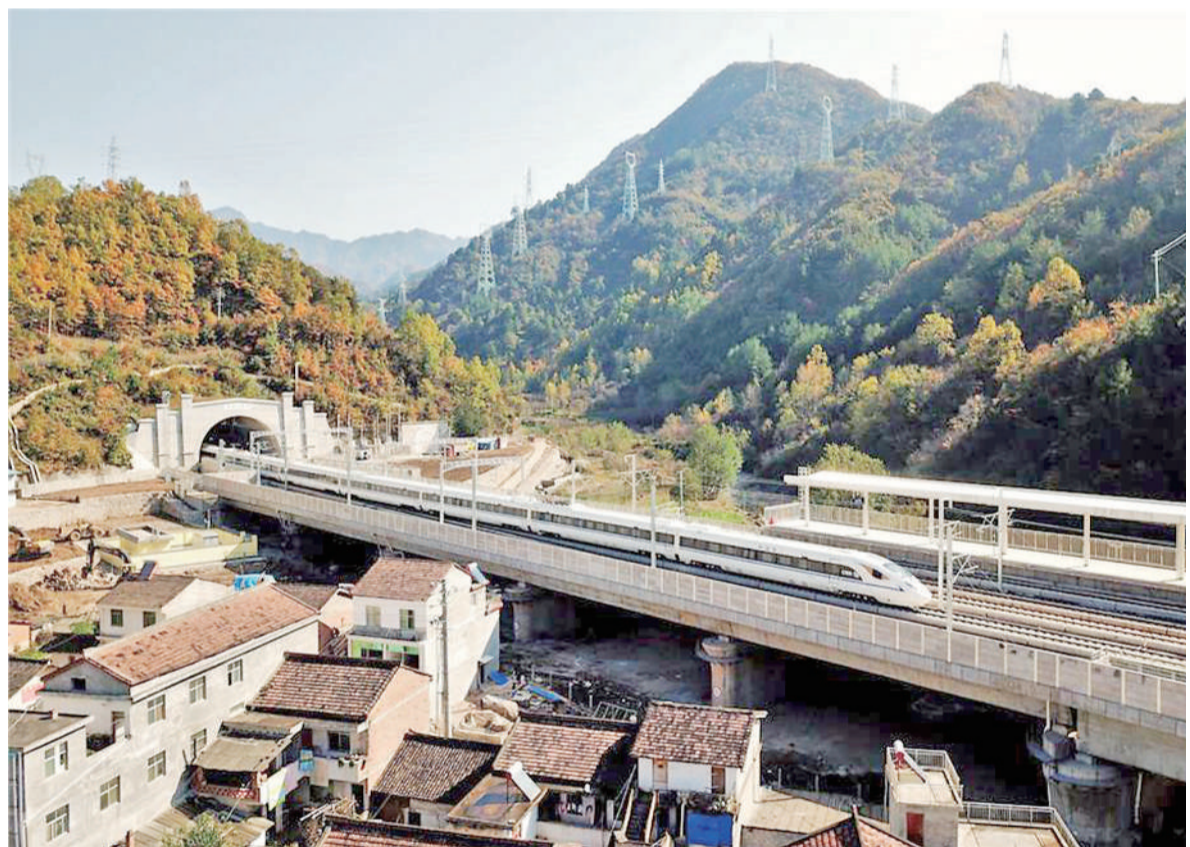
一列动车组试验列车驶过秦岭深处的西成高铁佛坪站。
