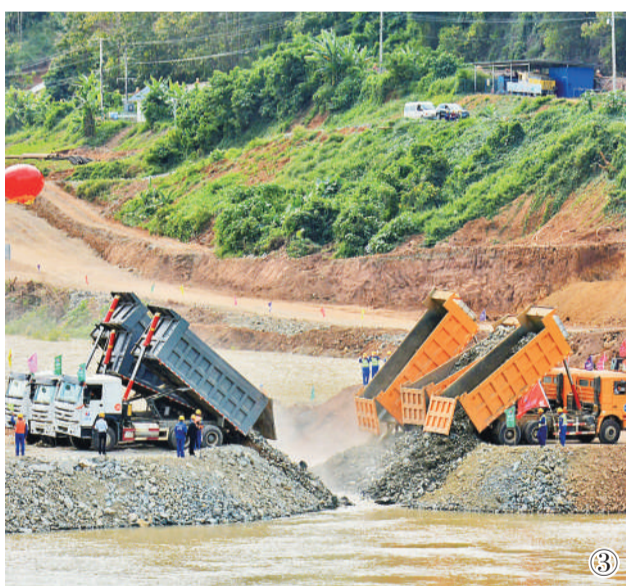
图③ 中国电力建设股份有限公司(中国电建)11月8日实现老挝南欧江项目二期一级、七级水电站同步截流,大幅推进中国电建境外首个完整流域水电开发项目。
