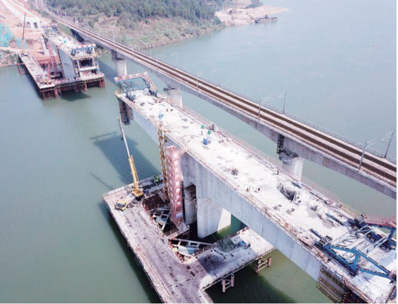
10月27日，全国第一座大跨度无砟轨道高速铁路特大桥——昌赣高铁赣江泰和特大桥正在紧张施工建设中。昌赣高铁赣江泰和特大桥位于江西泰和县，全长6.839公里，设计时速350公里。
