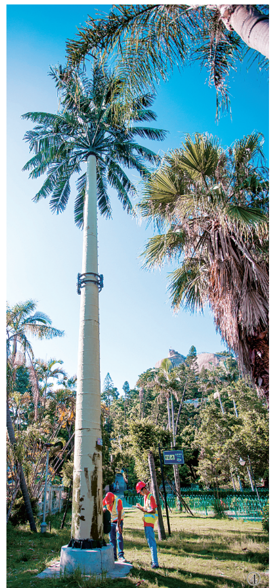
图④ 图为海南的通信基站,被装点得像椰子树一样,融入了自然环境。 本报记者 黄鑫摄
