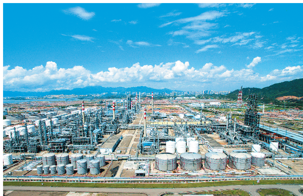
加强工业节能。2012年至2016年,全国规模以上工业企业单位工业增加值能耗累计下降约29.5%。图为中海油惠州石化公司全面实施节能技术改造,和2012年相比,电耗下降12.5%,年节电6150万千瓦时。
