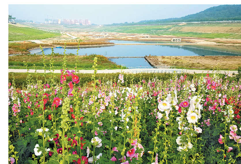
加大非常规水源利用。图为北京市西郊雨洪调蓄工程,通过水体自然下渗回补地下水。
