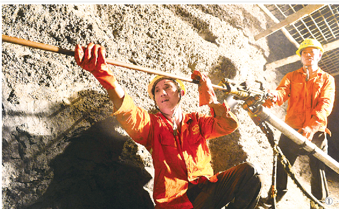
图① 中铁隧道集团开挖工黄华(左)和工友在施工面利用风钻打眼作业。
