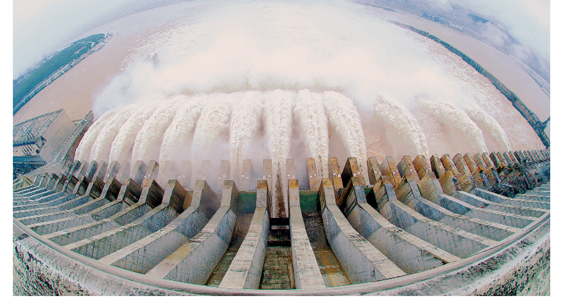
充分运用水利工程体系,科学调控洪水,减轻洪涝灾害损失。图为长江三峡水利枢纽工程泄洪俯瞰图。
