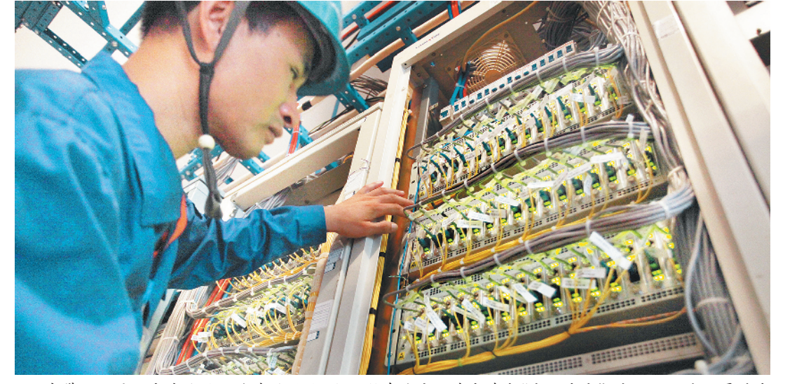
宽带网络是国家战略性公共基础设施,全国所有地市已基本建成“光网城市”,光纤网络广泛覆盖城乡,民众上网体验得到极大改善。图为技术人员在光纤信号收发器上为用户开通光纤信号电路。
