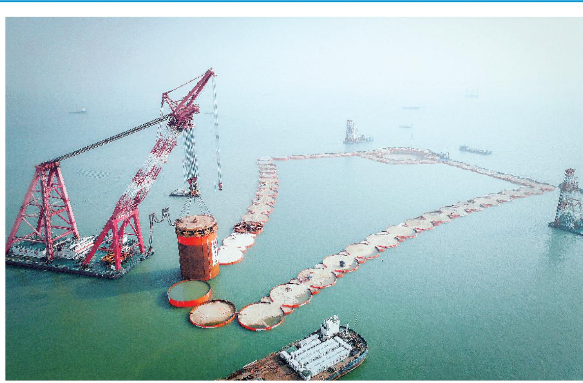
9月18日,最后一个钢圆筒到位后,深中通道西人工岛已初现“海上风筝”之形。当日,深中通道西人工岛最后一个钢圆筒精准沉到位,标志深中通道西人工岛正式成岛。深中通道位于珠三角核心区域,项目全长约24公里,是集超大跨径跨海桥梁、特长双向八车道海底隧道、海中人工岛和地下互通于一体的超大型跨海集群工程,建成后将成为连接珠江东西岸的重要通道。
