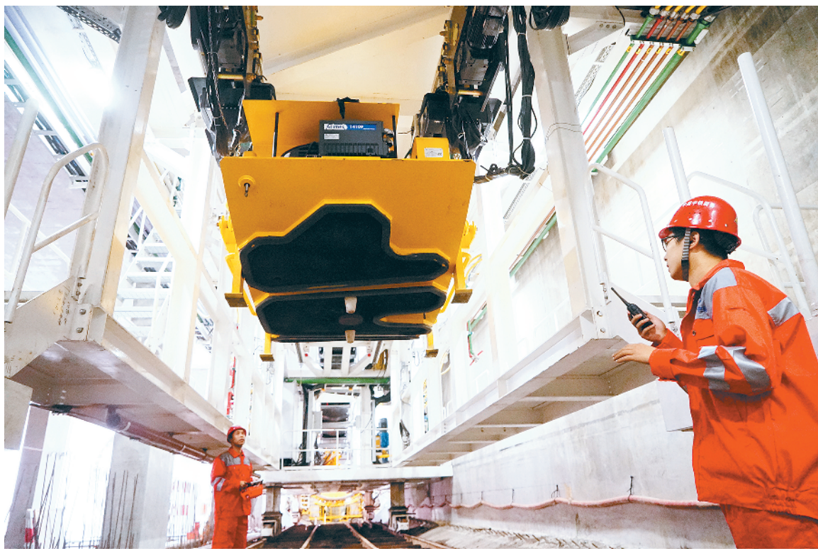
9月15日,北京大兴区新机场中段盾构施工现场,工作人员正在操作盾构机吊装设备。当日,直径8.8米的大盾构正式下井首发,标志着新机场轨道线盾构掘进施工拉开帷幕。新机场轨道线工程是北京首个采用PPP模式建设运营的轨道交通项目,采用城际铁路标准,应用新型市域车组,设计时速最高达到160千米,是目前国内最快的城市轨道交通工程。 本报记者 赵晶摄
