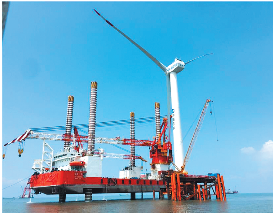
福清兴化湾30万千瓦海上风电场一期施工现场。
