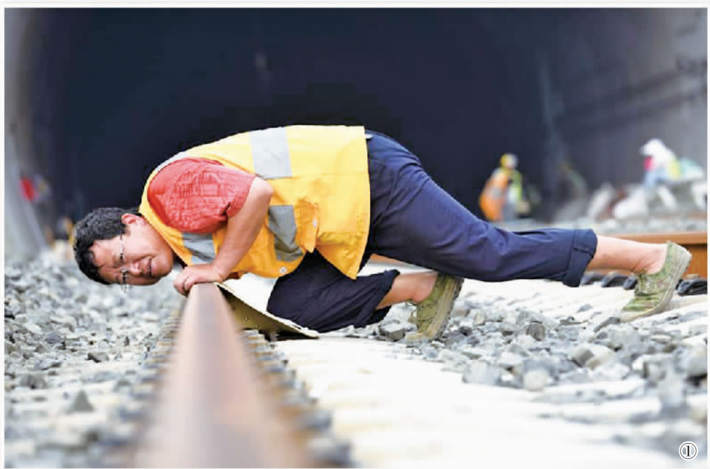
图1 改道作业一组班长付华伏在地上观察轨道是否平直。
