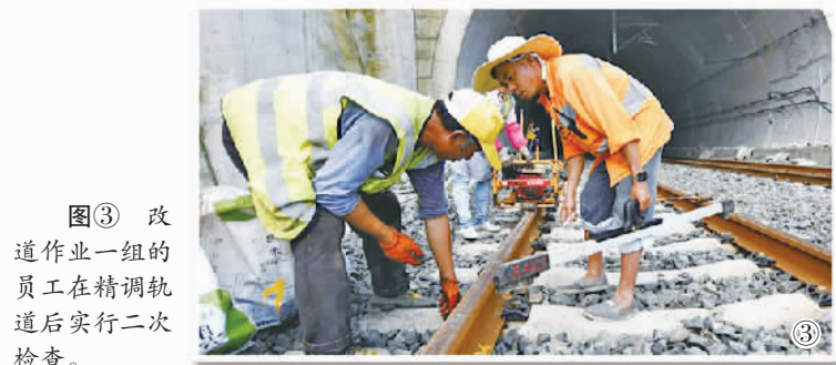
图2 改道作业一组的员工在用轨距改道设备对轨道进行精调。
