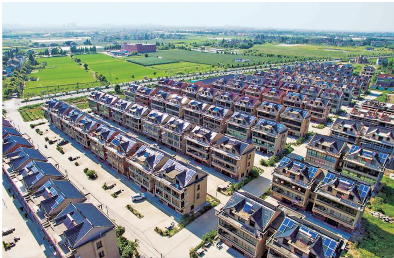
图为新建的光伏新村——浙江海宁彭墩村,现已初具规模。
