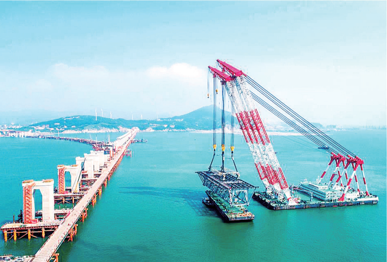
8月22日,由中铁大桥局打造“大桥海鸥号”起重船正在吊装平潭海峡公铁两用大桥首孔筒支钢桁梁。
