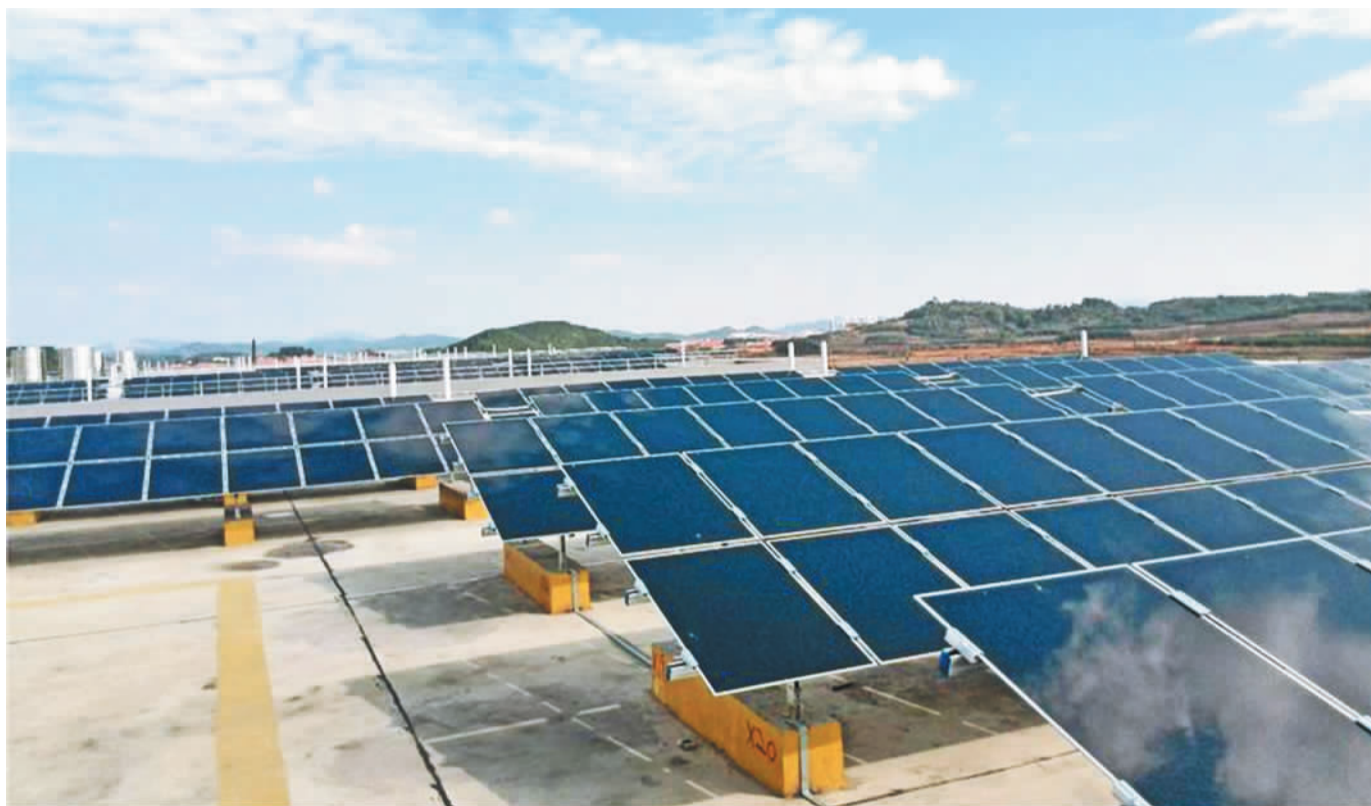
柳州职业技术学院的太阳能光伏发电板，发电之外，辅热可用于供应热水。
