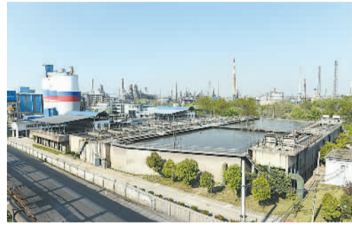
宝钢集团武钢绿色城市建设发展有限公司承建的港东水厂中水回用工程。
