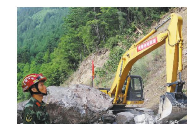
武警水电部队官兵在抢修九寨沟景区受阻通道。受地震影响，九寨沟景区震中45公里公路不同程度损毁，边坡垮塌、路基塌陷严重，并伴有大量滚石。目前九寨沟景区长海方向道路已经疏通，震中附近主要通道正抓紧全面抢通。
