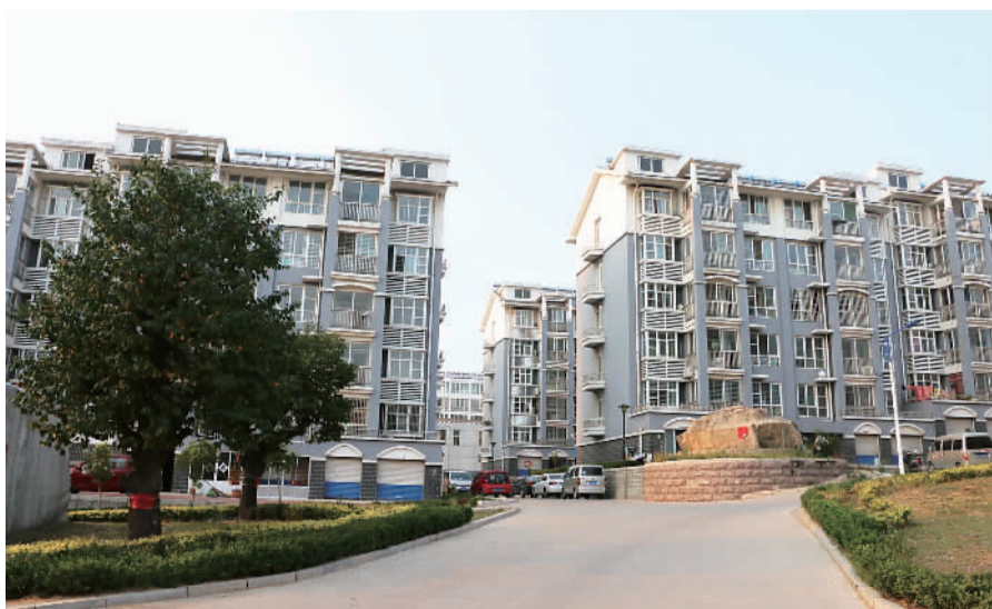
图为翟镇易地搬迁新建的社区。
