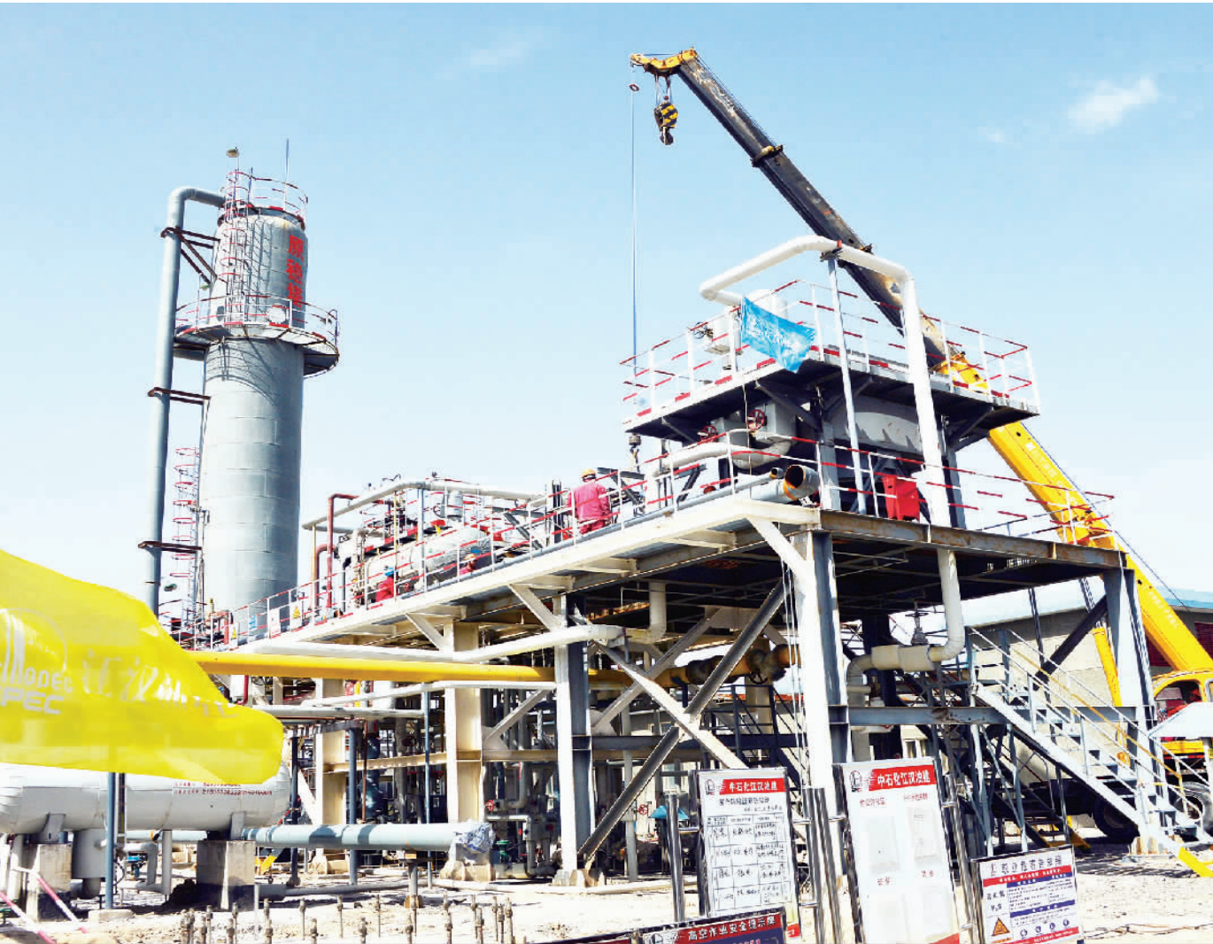
6月15日,西北油田采油一厂油气处理系统原油稳定部分实施技术改造,新增一座27米高负压闪蒸原油稳定塔一次吊装成功。为推进企业提质增效升级,该厂成立产品优化项目组对原油稳定塔进行改造,新增一个喷淋空冷器、一座负压闪蒸原油稳定塔,增加天然气提取工艺,每天可增加轻烃产量8.4吨、液化气3.6吨。 范明摄
