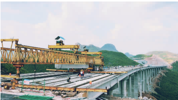
建设中的蒙文砚高速公路。
