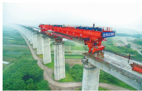
6月14日，随着最后一块800吨箱梁落座到乐山市五通江特大桥上，成贵铁路四川段线下工程全部结束，全面转向线上工程施工。成贵铁路建成后，成都至贵阳的时间可由现在的近12小时缩短为2小时，成都至广州将缩短至6小时。
