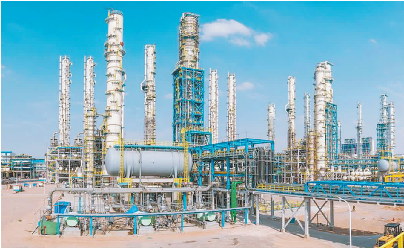
神华宁煤集团年产400万吨煤制油项目净化合成装置。
